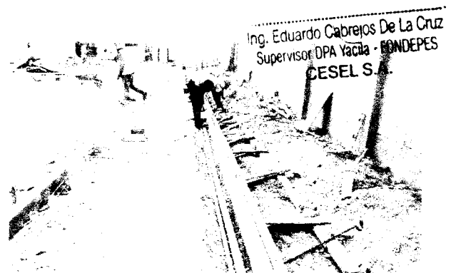
Foto 09 y 10: Tubería aprobadas por supervisor para su debida instalación, red de distribución agua potable a las zonas de servicios y tareas previas - ADICONAL N°06
